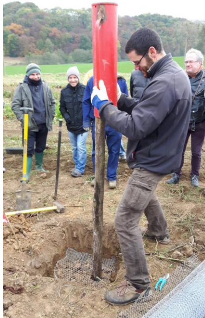
Enfoncement du tuteur avec un « enfonce-pieux »
