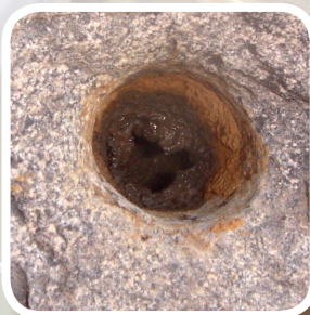
Pose du bouchon terminal en « diaphragme »
