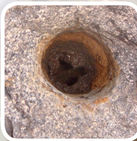
Pose du bouchon terminal en « diaphragme »
